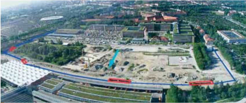
Abb. 4: Blick von Norden auf das ehemalige Gaswerksgelände mit Lage von Funnel (blau) und Gates (rot) sowie Grundwasser-Fließrichtung (Pfeil)
