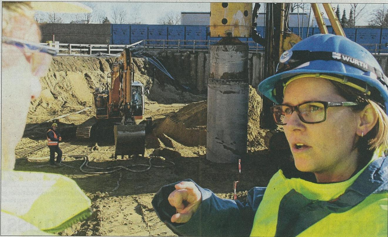
**Abgründe an der Autobahn:** Mit schwerem Gerät wird das belastete Erdreich herausgeholt und durch eine Zement-/Sandmischung ersetzt. Bianca Thiel von der Firma BFM Umwelt (oben rechts) nimmt regelmäßig Bodenproben. Die Autobahnauffahrt in Richtung München (unten rechts) ist derzeit noch für den Verkehr gesperrt.
