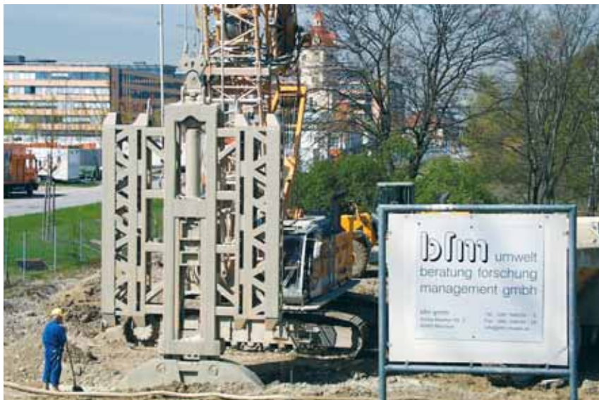
Abb. 7: Bau der Dichtwand
